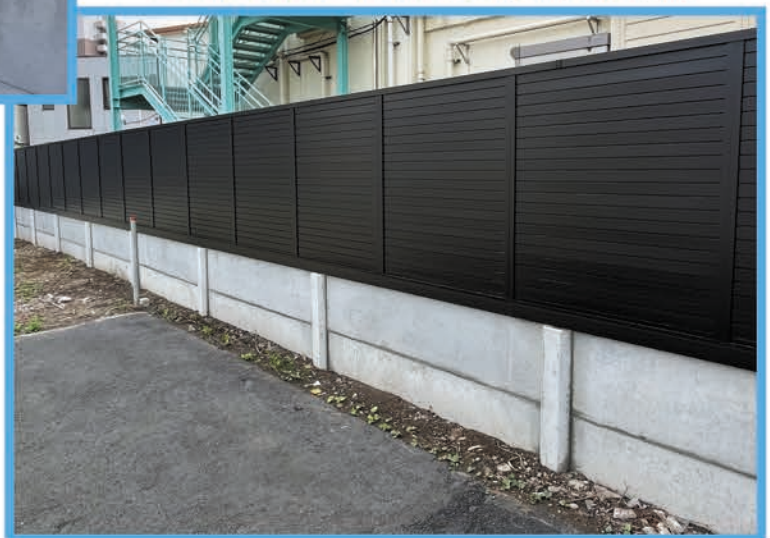
↓ フェンスウォールで土留め施工@公共施設
