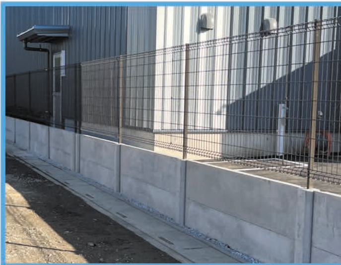
↑ 倉庫外周をフェンスウォールで施工
