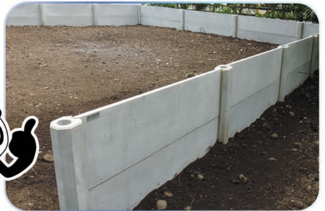
傾斜地に施工
