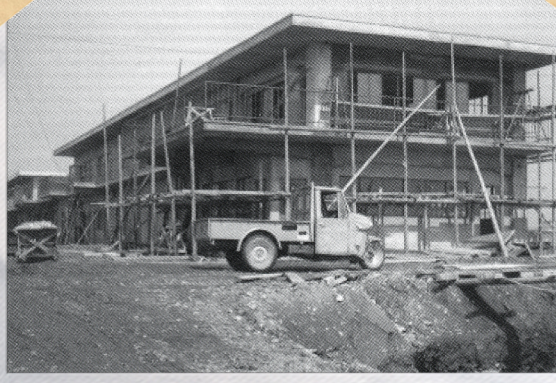
昭和42年 事務所竣工間近の様子
