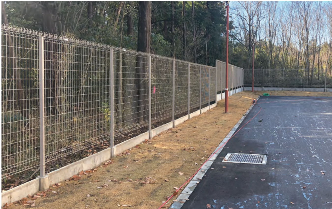
茨城県 農場外周フェンス工事 フラット1番
