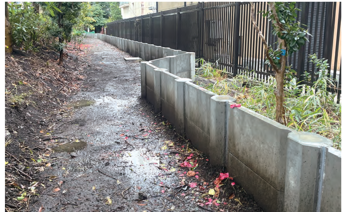
東京都 止水フェンス工事 ワイド 2 番
