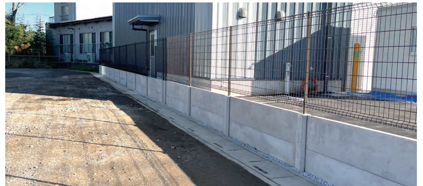
埼玉県 境界フェンス工事 フラット2番
