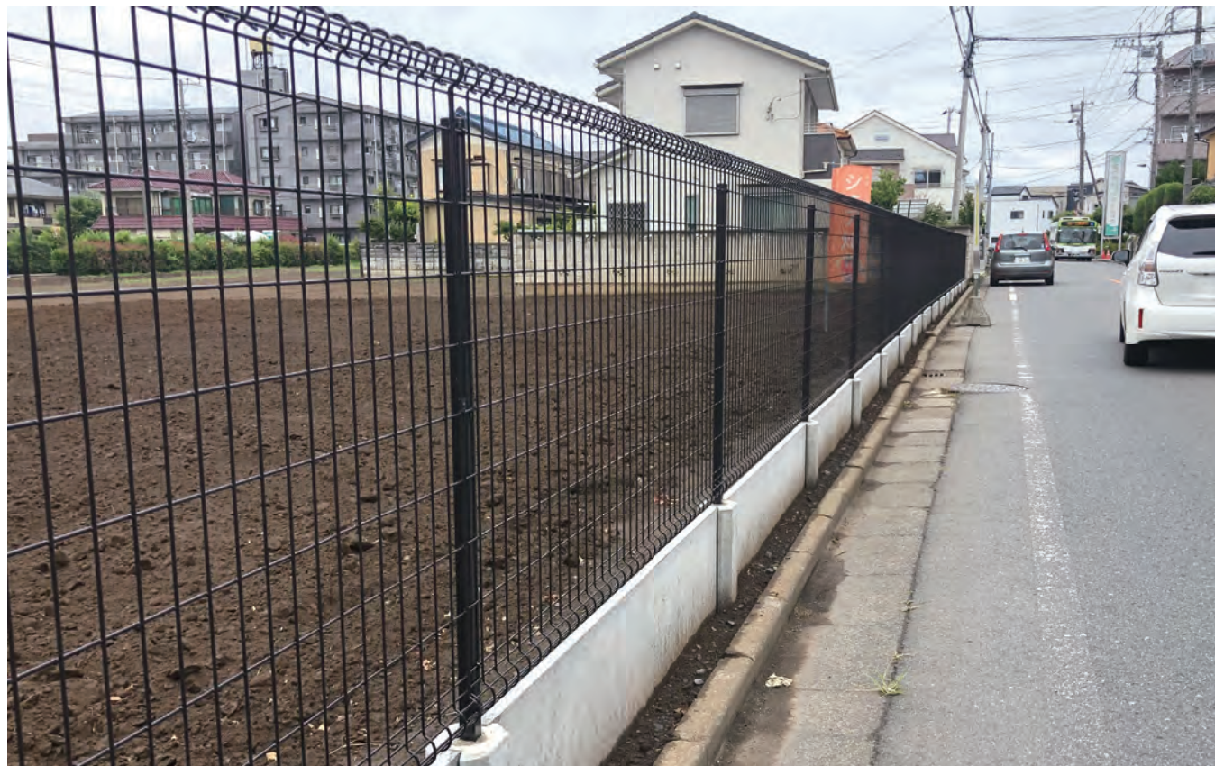
埼玉県 農地境界フェンス工事 フラット1番
