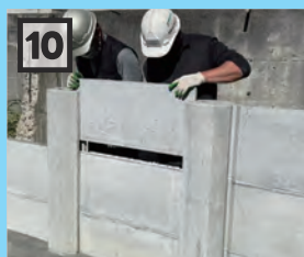
3段目を重ねる。重ねる時は シリコンコーキング材を充填 すること
