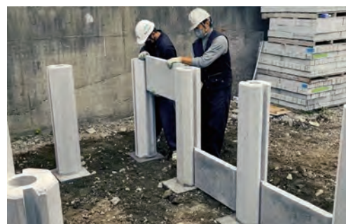
【ミヤコWG】貯水試験施設 施工中
