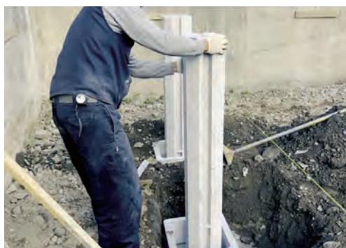
【ミヤコWG】貯水試験施設 柱建て込み
