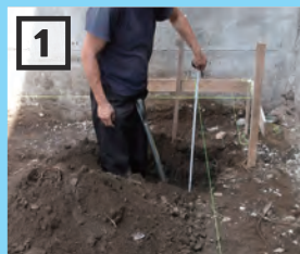
柱を建てる為の穴を掘る
