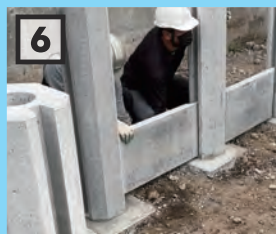
耐圧板の向きは外側に厚み がある側を向けるが、厚みが 無い側でも試験したが 問題ない
