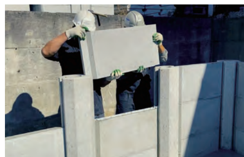
【ミヤコWG】貯水試験施設 施工中
