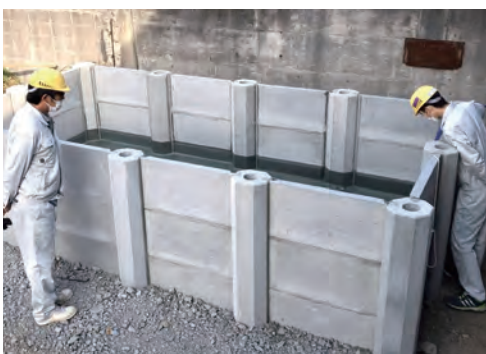
【ミヤコWG】貯水試験施設 施工後注水開始
