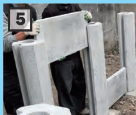
根固めコンクリートの養生 期間をい経て、柱に耐圧板を 差込みます
