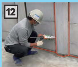
モルタルで埋めた縦目地と 土間コンクリートの境目に シーラーを塗布し、シリコン コーキング材で目地打ち
