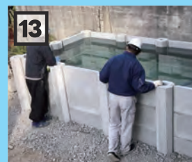
フェンスウォール 貯水工法の施工完了
