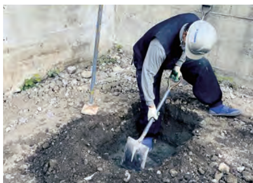
【ミヤコWG】貯水試験施設 掘削
