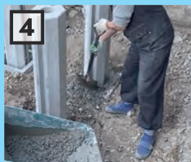
根固めコンクリートを流し込 みます根固めコンクリートの 寸法をお守りください
