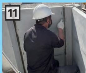
モルタルで縦目地を埋める
