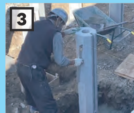
柱が垂直に建つように調整 柱と柱の間隔を正確に
