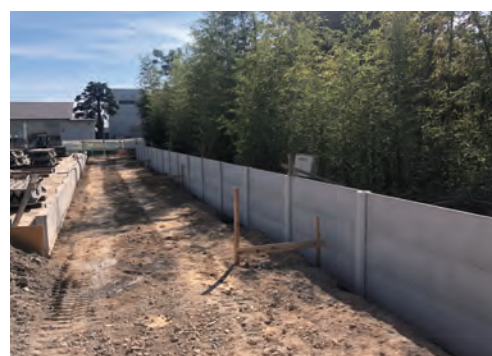
【フラット】竹害対策 施工途中
