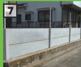
フェンスウォールの施工完了
