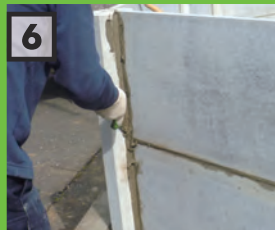
柱と土圧板の継ぎ目（縦目地）を埋めていきます
