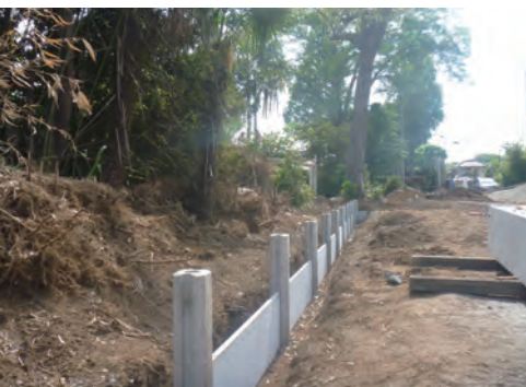
【フラット】1番 1スパンを2mで施工
