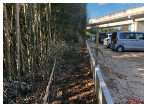
【フラット】竹害対策 施工途中
