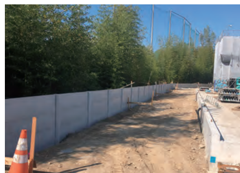
【フラット】竹害対策 施工途中
