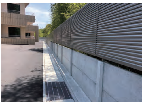
【フラット】2番 1スパンを1mで施工
