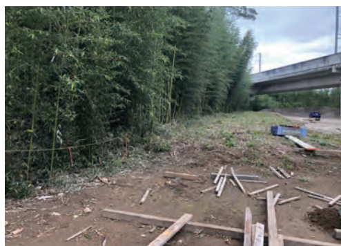
【フラット】竹害対策 施工前の様子
