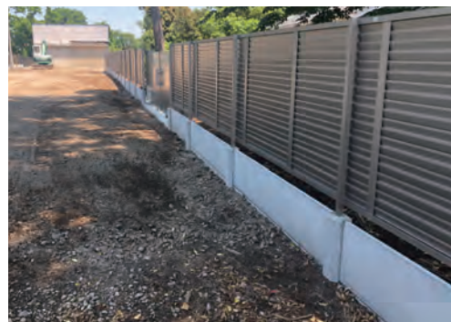
【フラット】2番 1スパンを2mで施工
