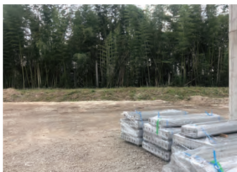
【フラット】竹害対策 施工前の様子
