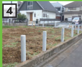
必要な柱をすべて設置する
