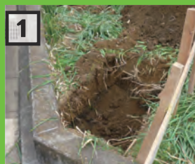
柱を建てる為の穴を掘る
