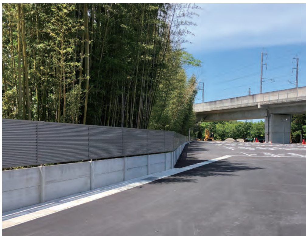
【フラット】竹害対策 施工完了
