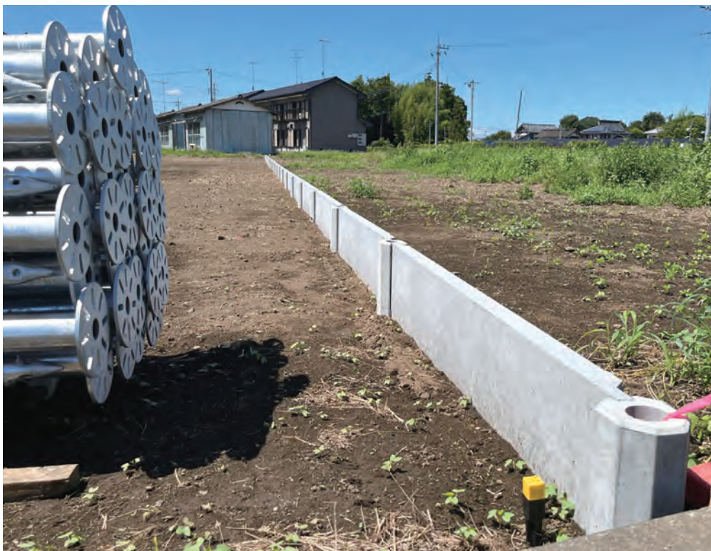
【フラット】1番 1スパンを2mで施工
