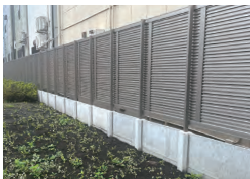
【フラット】2番 1スパンを1mで施工
