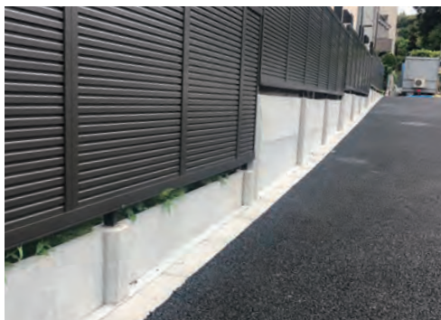
【フラット】傾斜地へ施工
