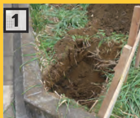
柱を建てる為の穴を掘る
