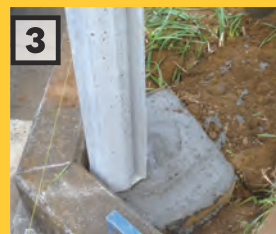
コンクリートを流し込み柱を根固めます
