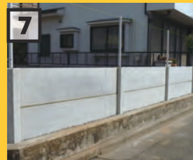
フェンスウォールの施工完了
