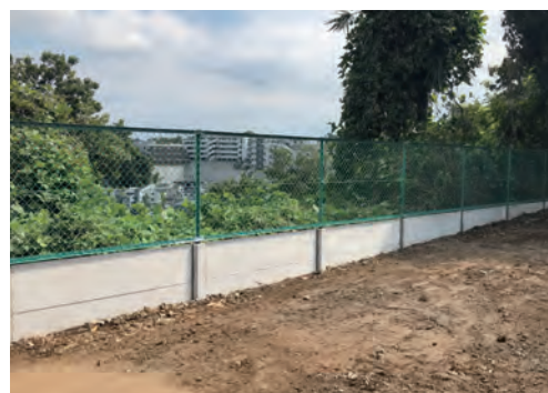
【フラット】2番 1スパンを2mで施工
