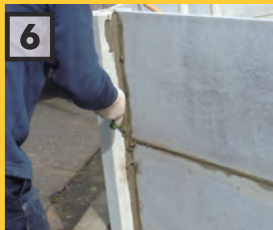
柱と土圧板の継ぎ目（縦目地）を埋めていきます
