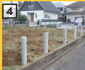
必要な柱をすべて設置する
