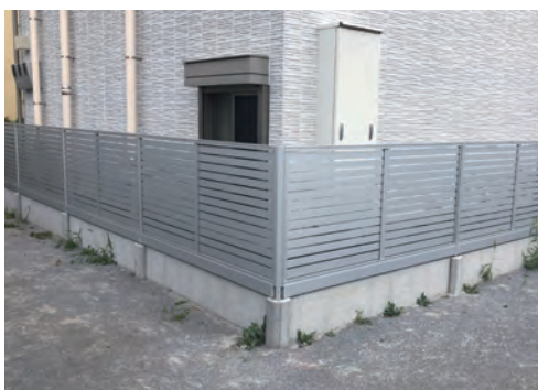
【フラット】1番 1スパンを2mで施工
