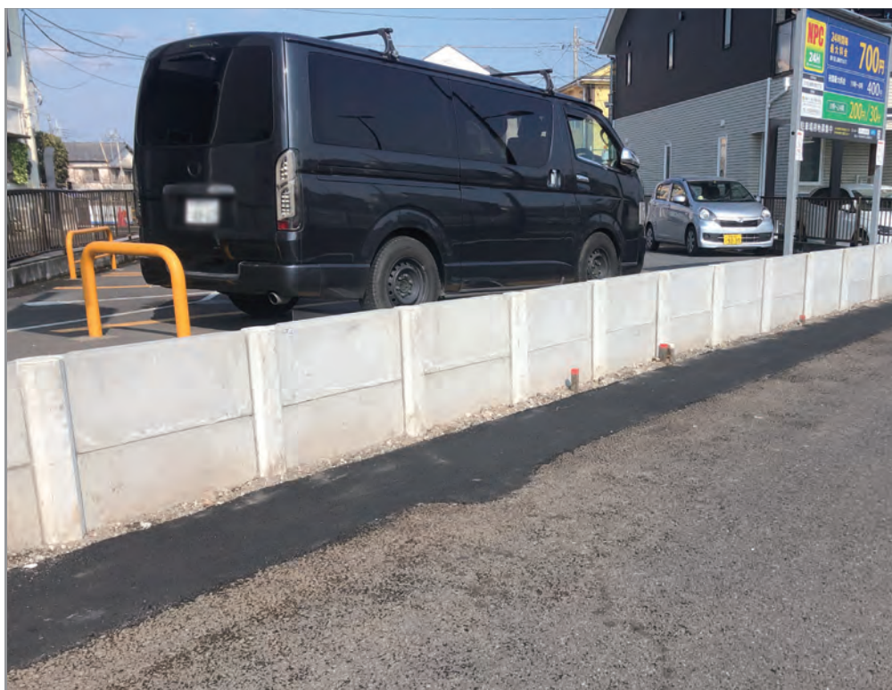
【フラット】1スパンを1mで施工、盛土60cm程度の土留め
