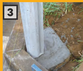
コンクリートを流し込み柱を根固めします
