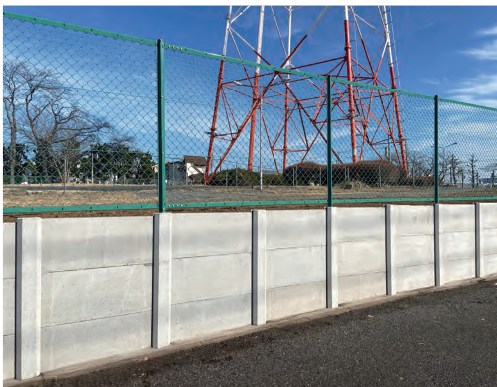
【フラット】3番 盛土1m 傾斜地にもこのように段差をつけて施工できます
