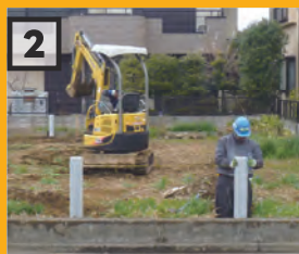
柱を建て、柱と柱の間隔を正確に測る
