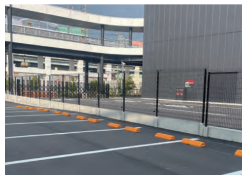
【フラット】千葉県商業施設
