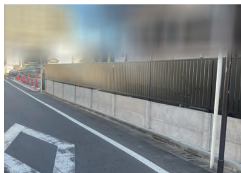
【フラット】2番 1スパンを2mで施工
