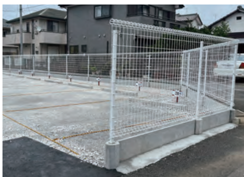
【フラット】1番 1スパンを2mで施工
