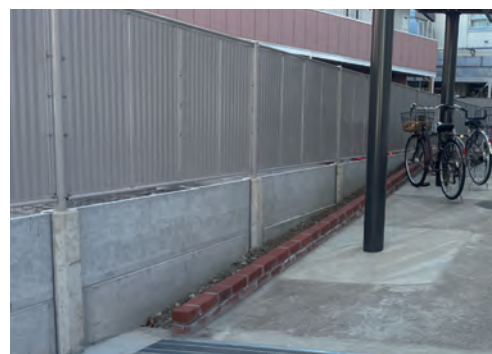
【フラット】2番 東京都公共施設
