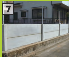
フェンスウォールの施工完了
