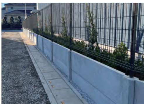
【フラット】2番 1スパンを2mで施工
