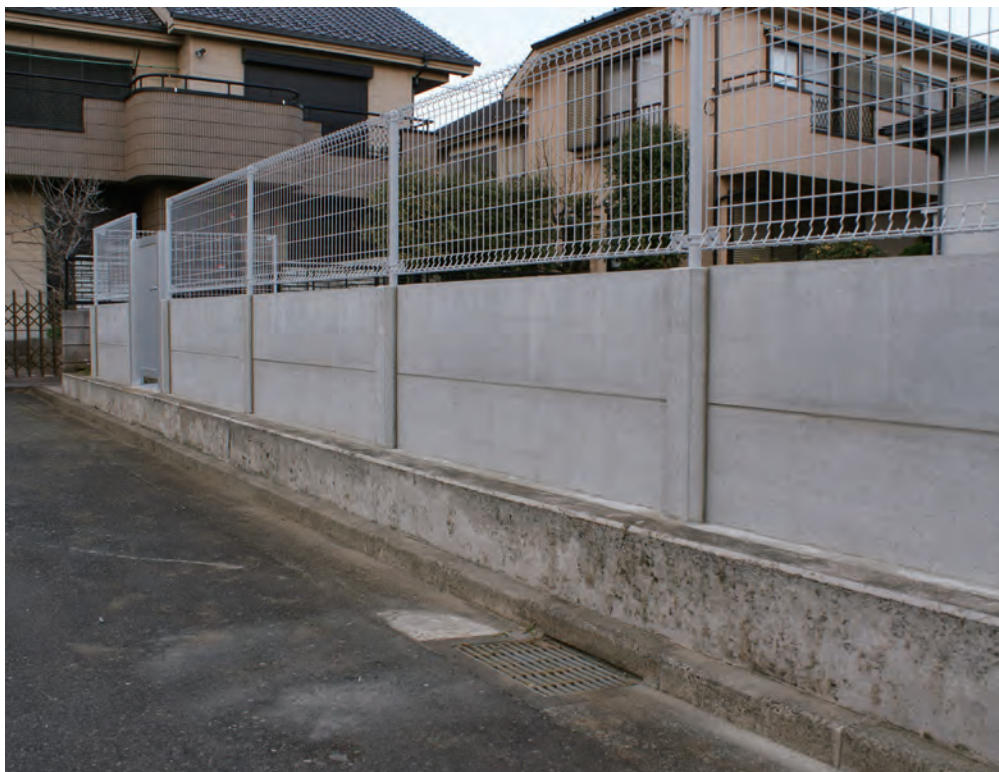
【フラット】2番 1スパンを2mで施工 メッシュフェンスを設置
