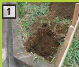
柱を建てる為の穴を掘る
