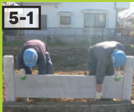
設置した柱と柱の間に土圧板を差込み、板目地を打つ
