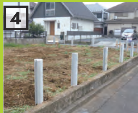
必要な柱をすべて設置する
