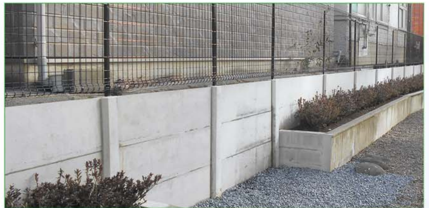
最大高さ1メートルの土留めを構築できます
