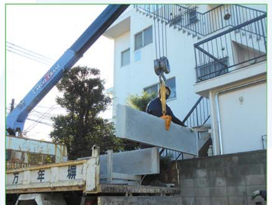
柱が立ち上げれば土圧板を次々入れて、完成
