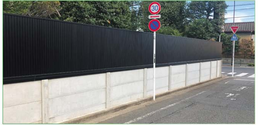
【重厚なフェンス基礎】 コンクリート特有の重厚感
