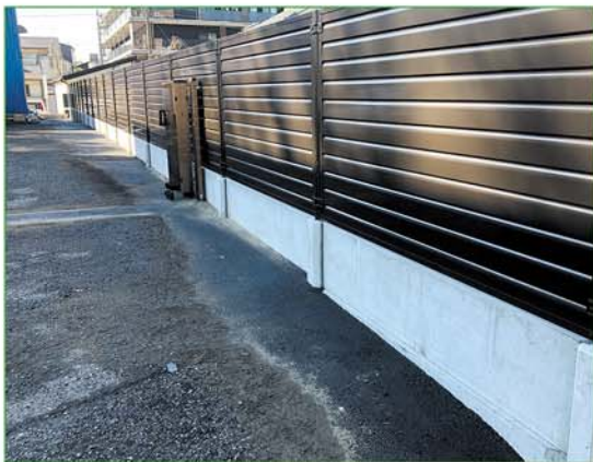
土圧の掛かる場所のみ土圧板、上部は通常柵板
