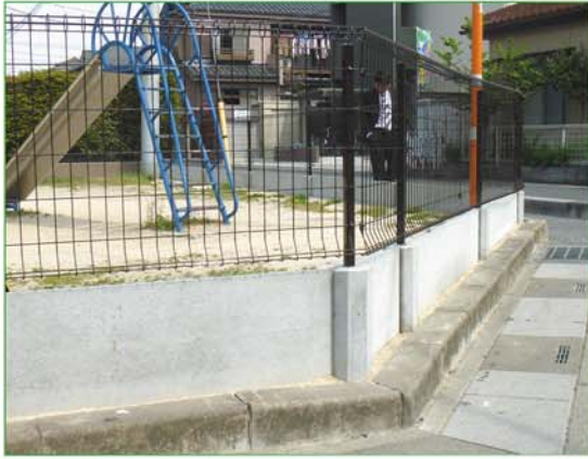
【土の流出防止】 や 【防草対策】
